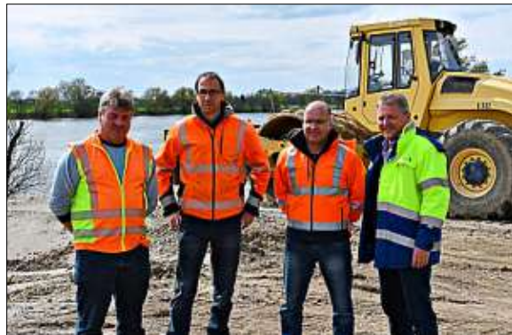
Informieren über die Bauarbeiten: Ludwig Kubitschek (v.l.), Dominik Zehatschek und Thomas Hois von der Wiges sowie Wolfgang Leuzinger vom Wasserwirtschaftsamt.
