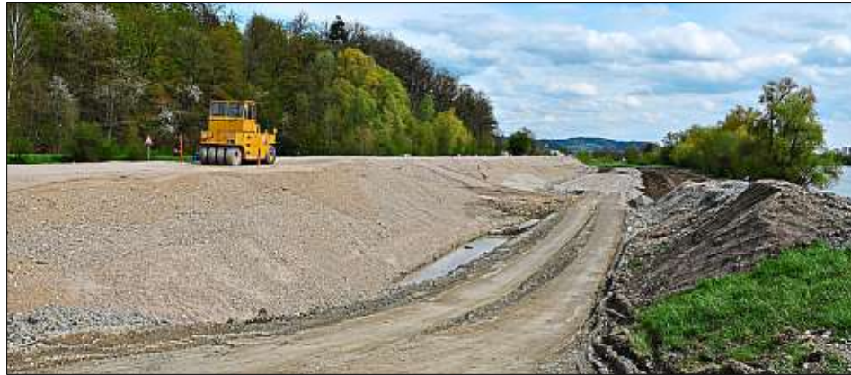
Die Arbeiten entlang der Staatsstraße: Der neue Deich ist im östlichsten Abschnitt schon so hoch, dass der alte abgetragen werden konnte.
