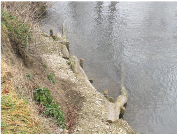
Bild 10: Einbau von Totholz an der Rott bei Zellhub
