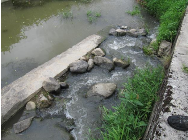
Bild 2: Tümpelpassanlage beim Kraftwerk Söldenau
