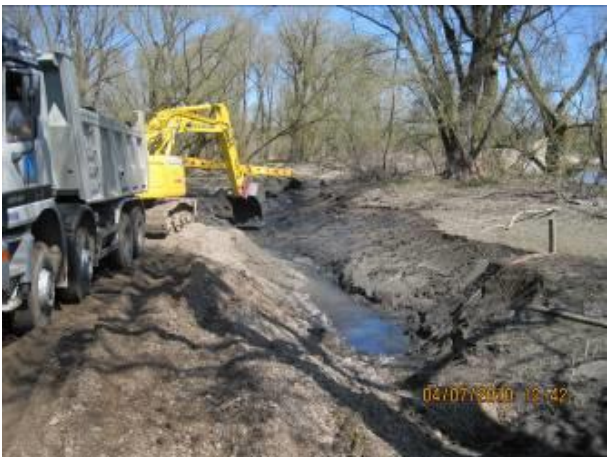
Bild 15: Anbindung eines Altwassers an der Vils
