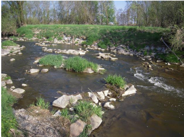
Bild 4: aufgelöste Sohlrampe an der Rott bei Lengham
