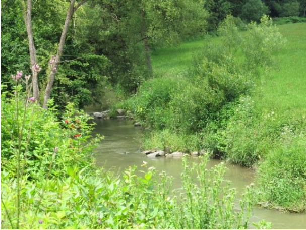
Bild 9: Wolfach bei Fluss-km 5.800. Durch den Einbau von kleinen Buhnen hat sich die Strömungsvielfalt verbessert.
