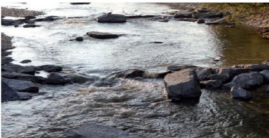
Abb. 40: Schwellen (Tümpelpass mit gut passierbaren Hauptübergängen, gute Energieumwandlung.)
