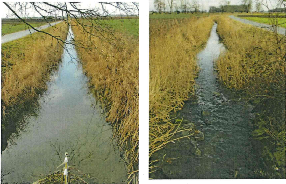
Abb. 4: Reißinger Bach östlich Wallersdorf – links: geradliniger, strukturarmer Verlauf, rechts: wechselnde Gewässerbreiten, Sohl- und Strömungsvielfalt
