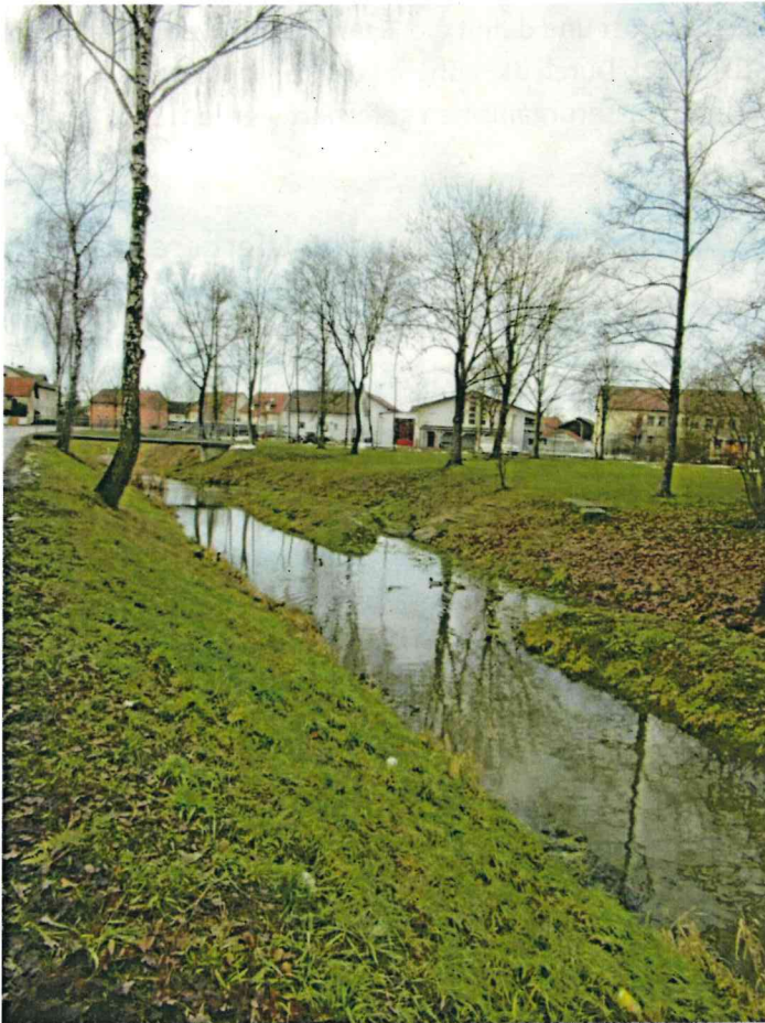
Abb. 5: Reißinger Bach in Wallersdorf – Abtrag Ufer, Aufweitung Bach und Anlage Inseln
