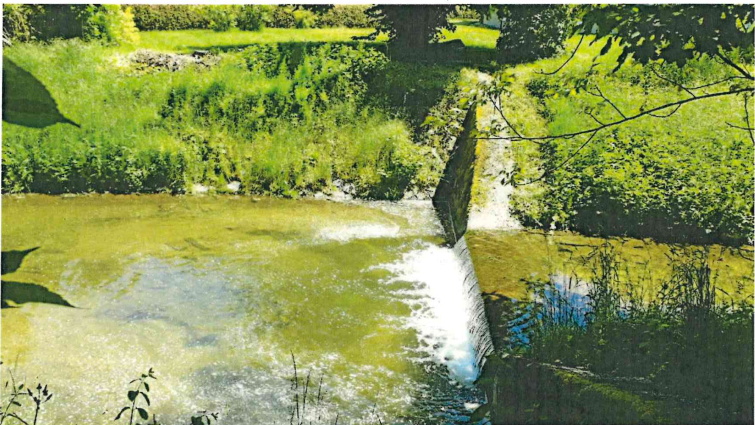
Abb. 1: Absturz im Reißinger Bach westlich Wallersdorf
