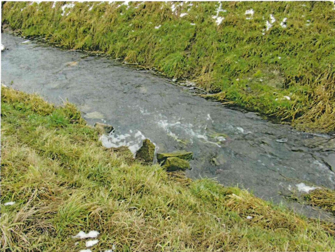
Abb. 3: Aufgelöster Uferverbau am Reißinger Bach westlich von Wallersdorf
