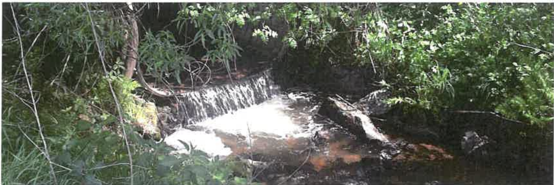
Abb. 1: Sohlschwelle am Freibach (F23 Fkm 6,22; Quelle PAN)
