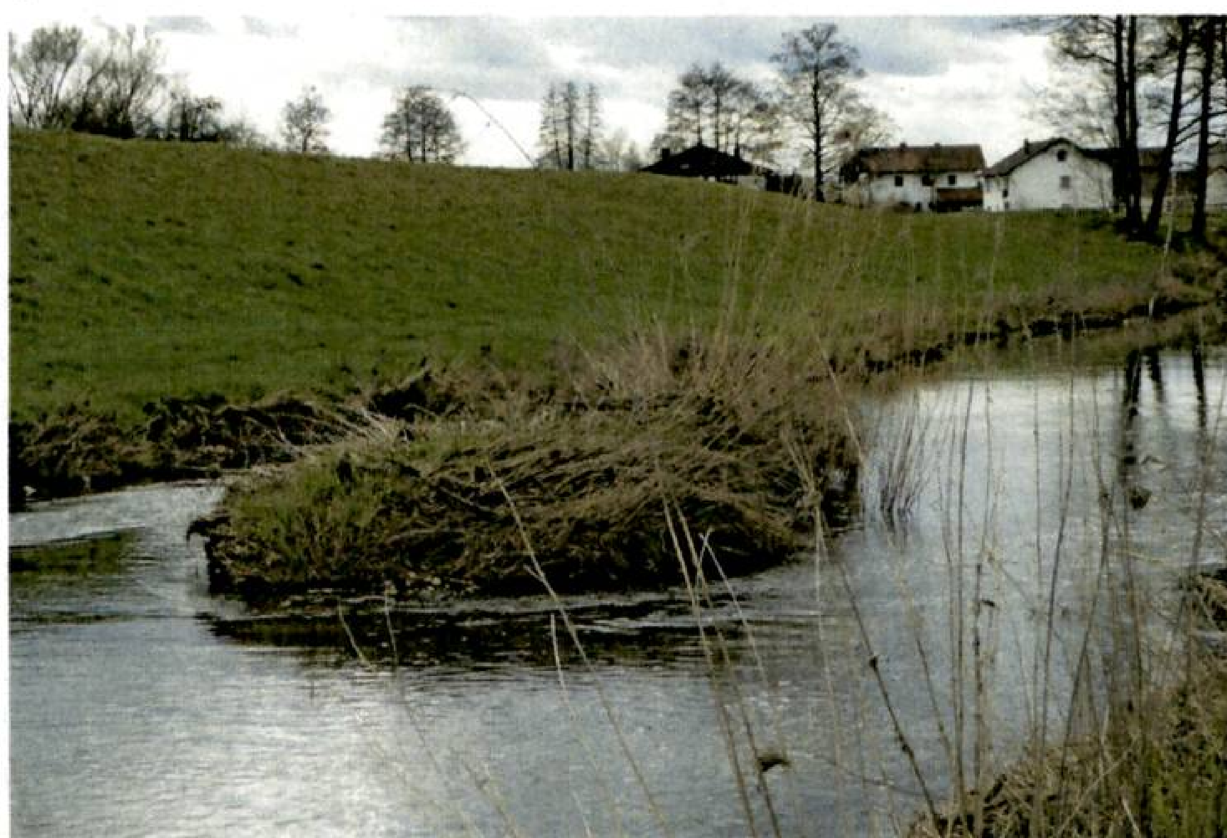
Abbildung 1: wenig Strömungsvariabilität trotz bereits einseitig aufgelockerter Uferlinienführung (Fluss-km 6,500)
