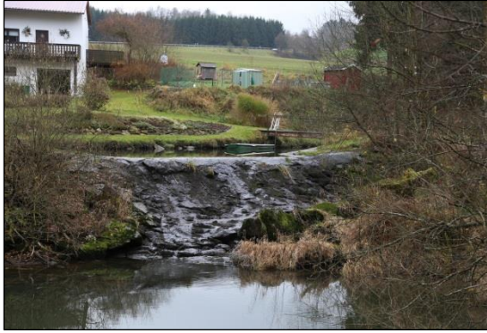
Bild 1: Wehr am Kraftwerk Klingermühle bei Fluss-km 20,500
