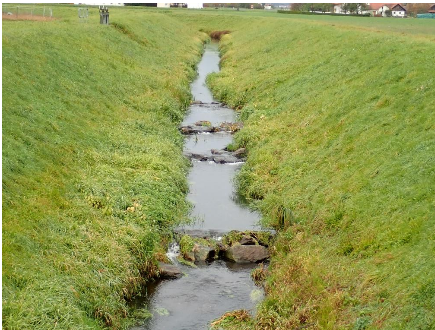
Abbildung 4: Sohlschwellen und gerader Gewässerverlauf im Spitzraingraben
