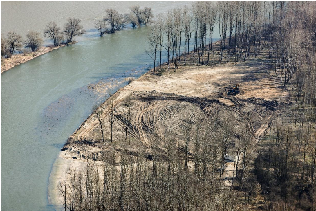
Abb. 108: Geländemodellierung am rechten Isarufer Arbeiten (Foto: Befliegung WWA 2006)
