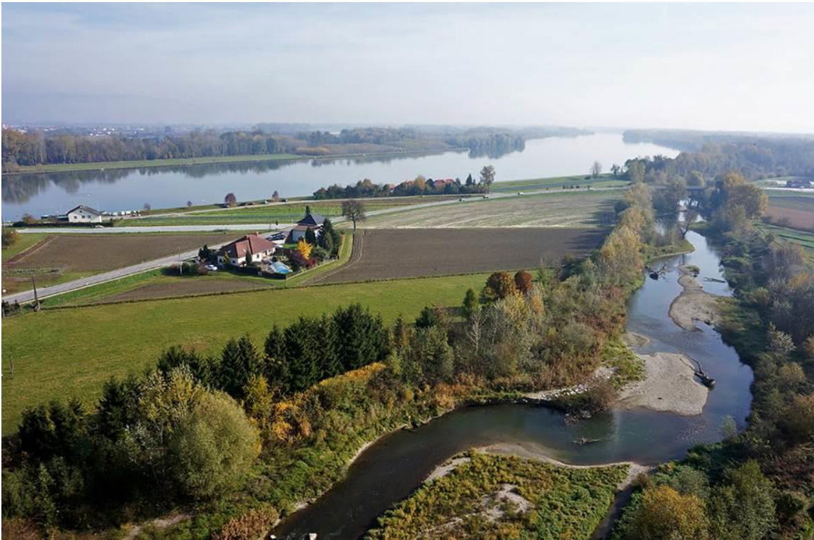
Abb. 117: Dynamischer Umgehungsarm am Donaukraftwerk Ottensheim-Wilhering. Aufgrund der hohen Abflussdynamik ( MQ = 6,3 \text{ m}^3/\text{s} , MJHQ \sim 140 \text{ m}^3/\text{s} im fotografierten Abschnitt) bleiben fließgewässertypische Schlüsselhabitate dauerhaft erhalten.
